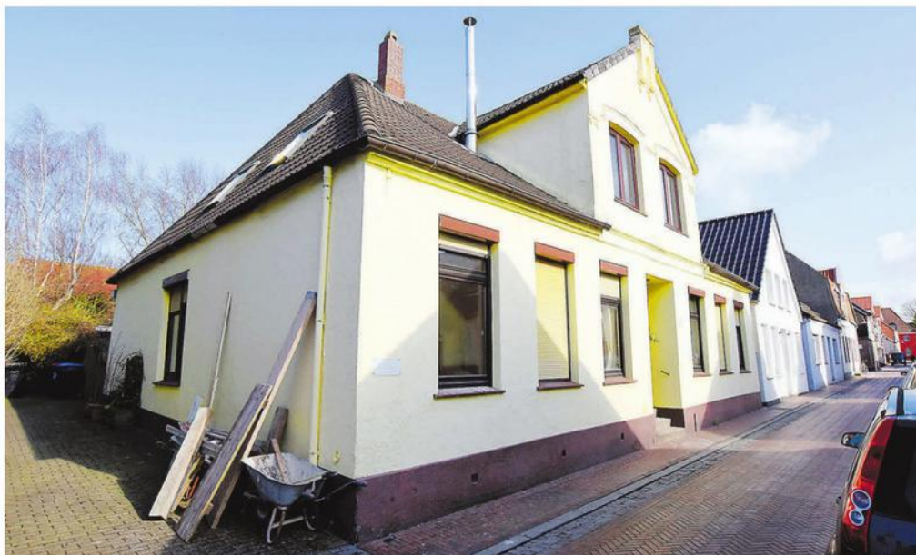
Im Weinberghaus an der Schüttingstraße 13 sind seit dieser Woche in der linken Erdgeschosswohnung Handwerker am Werk. Dort soll ein Erinnerungsort für die jüdische Geschichte Varels entstehen.
