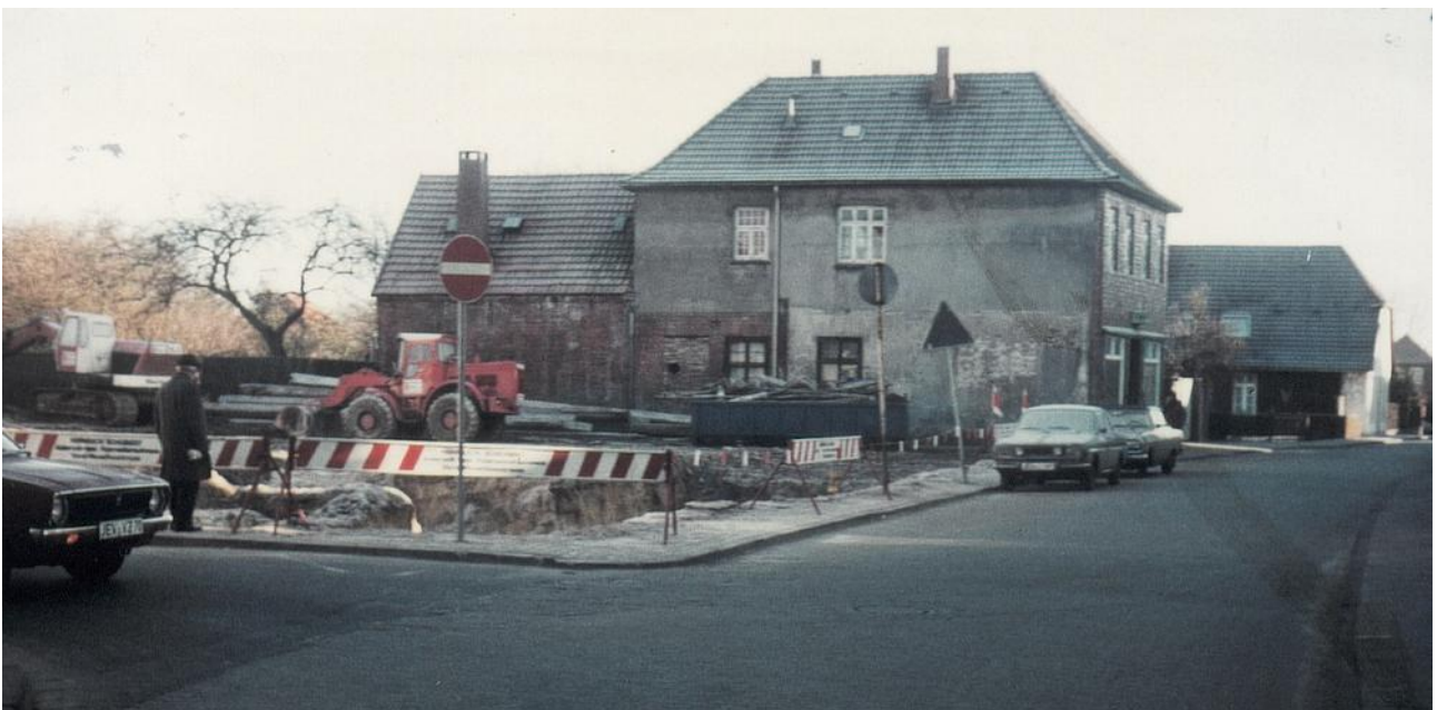
Abb.: Foto nach dem Abriss der „Schwabe-Villa“, 6. Dezember 1975. Sammlung Frerichs.
