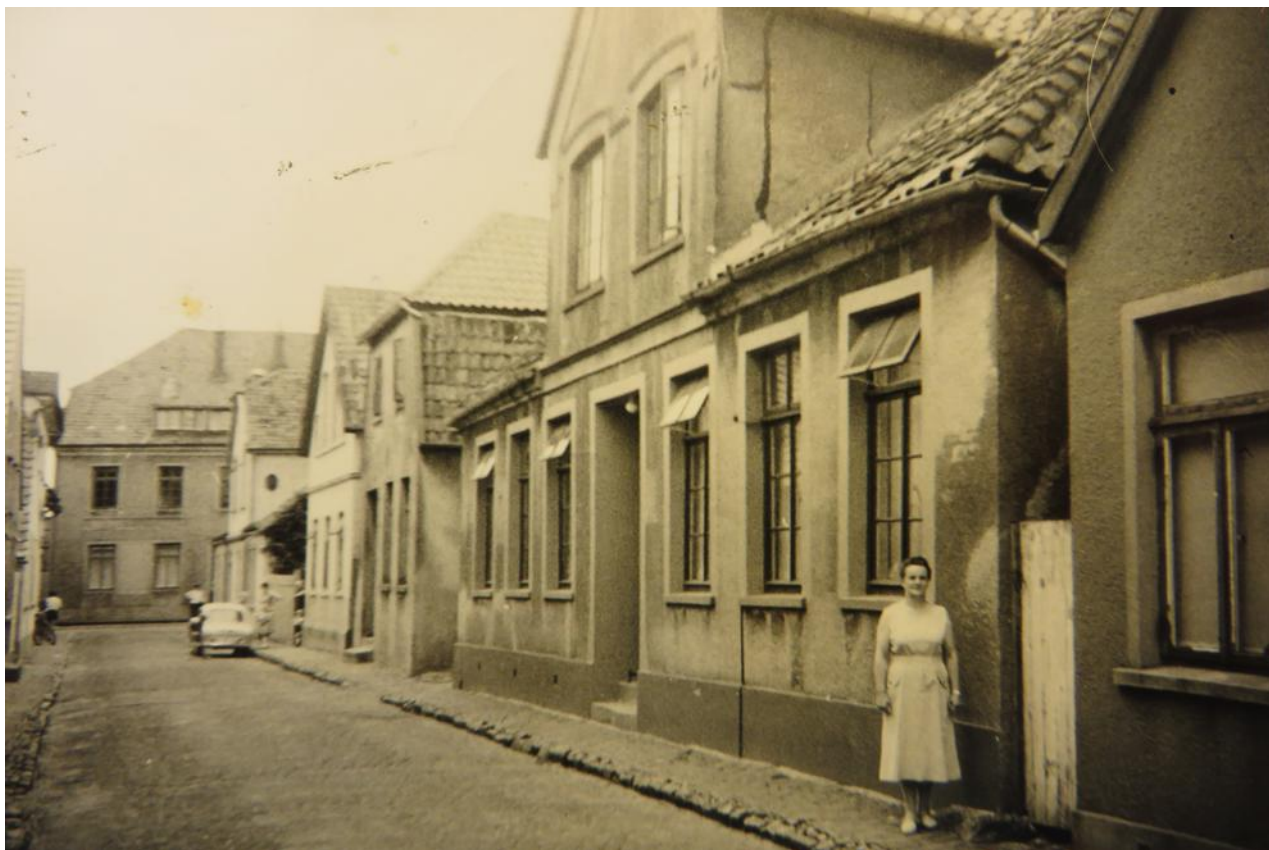
Abb. 5: Varel, Schüttingstraße. Die Person auf dem Foto steht vor der Hausnummer 13, dem ehemaligen Jüdischen Altenheim (1937 bis 1942), 1941/42 Aufenthaltsort von Moses und Emma Wolffs. Ein zeitgenössisches Foto aus dem Zeitraum 1937 bis 1942 ist bisher unbekannt (Arbeitskreis Weinberghaus Varel).
