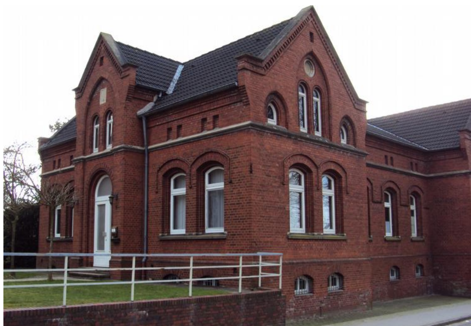
Abb. 4: Dieses Gebäude in Varel, Schulstraße Ecke Schlossplatz, diente im November 1938 als Polizeigefängnis. Die Zellen befanden sich im Kellergeschoss (Foto: Frerichs 2015).
