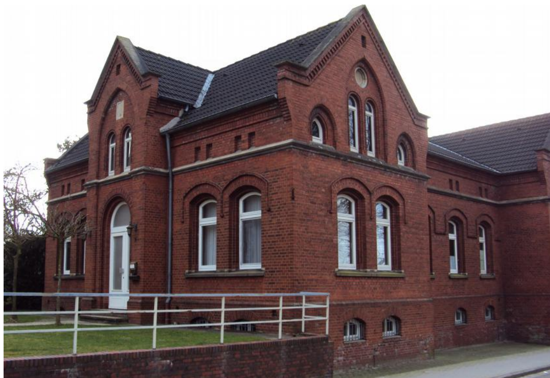
Abb. 5: Dieses Gebäude in Varel, Schulstraße Ecke Schloßplatz, diente im November 1938 als Polizeigefängnis. Die Zellen befanden sich im Kellergeschoss (Foto: Frerichs 2015).
