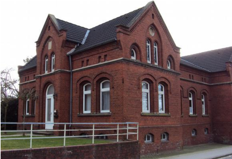
Abb.: Dieses Gebäude in Varel, Schulstraße Ecke Schlossplatz, diente im November 1938 als Polizeigefängnis. Die Zellen befanden sich im Erdgeschoss (Foto: Frerichs 2015).
