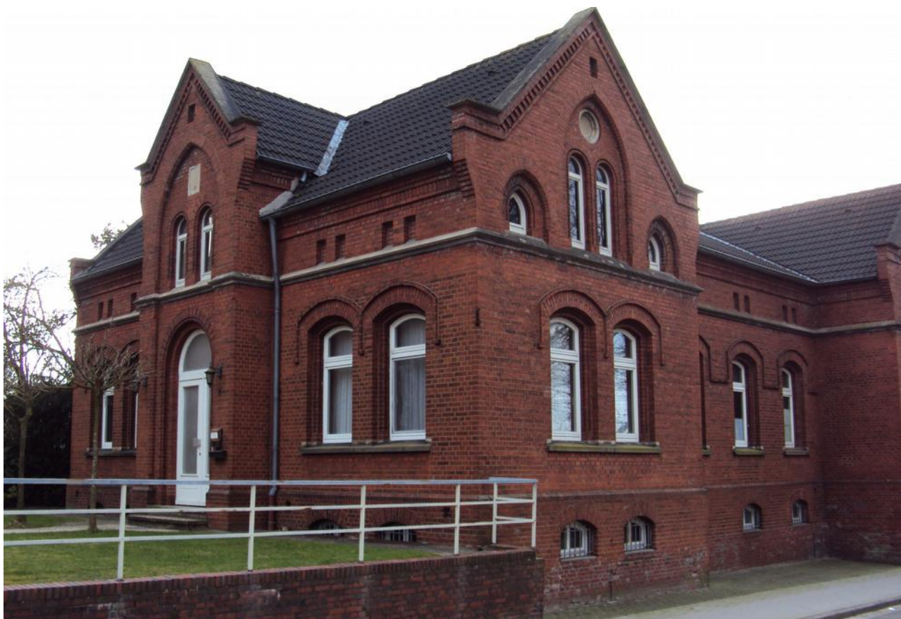
Abb. 9: Dieses Gebäude in Varel, Schulstraße Ecke Schloßplatz, diente im November 1938 als Polizeigefängnis. Die Zellen befanden sich im Kellergeschoss (Foto: Frerichs 2015).
