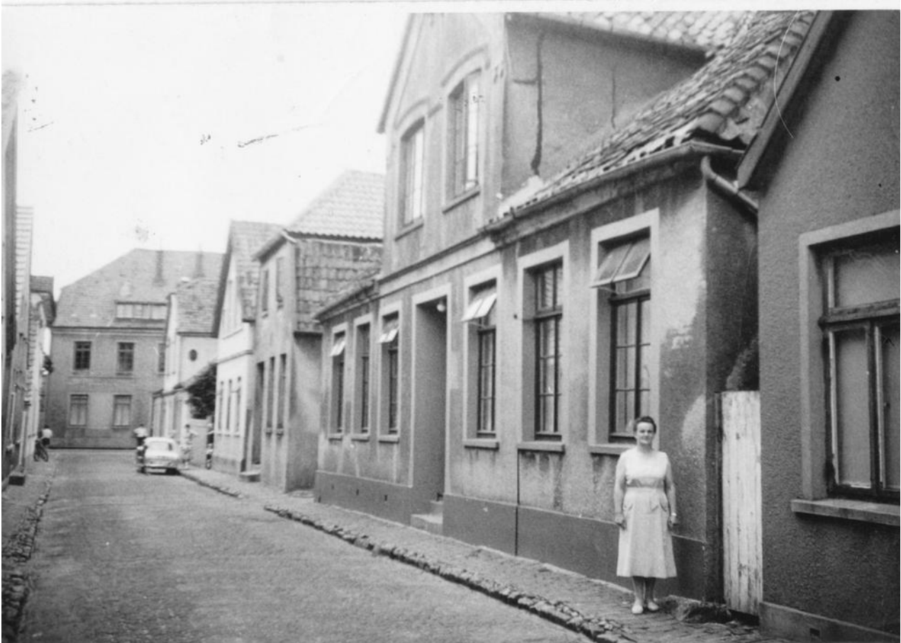
Abb.: Varel, Schüttingstraße. Foto 1955. Die Person steht vor der Hausnummer 13, Wohnhaus der Familie Weinberg und von 1937 bis 1942 Jüdisches Altenheim. Zeitgenössische Fotos aus der ersten Hälfte des 20. Jahrhunderts sind bisher unbekannt. Arbeitskreis Weinberghaus Varel.
