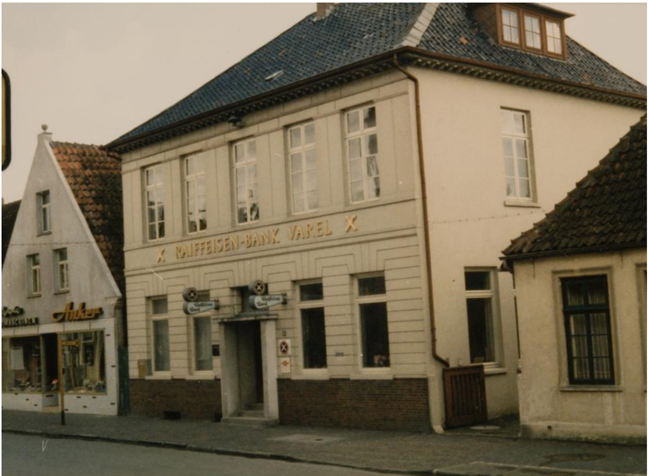
Abb. 10: In diesem Gebäude befand sich bis in die 1920er Jahre das Wohnhaus und Bankgeschäft von Max Wallheimer. 1934 zog dort die Raiffeisenbank Varel ein. Es folgten verschiedene Umbauten und Erweiterungen, die das heutige Gesicht der Hausfront prägen. 1975 verlegte die Raiffeisenbank ihren Sitz. Seit 1986 befindet sich an dieser Stelle ein Geschäft für Papier- und Bürobedarf. Bild vor 1975. Archiv Heimatverein Varel.
