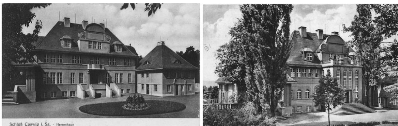
Abb. 33/34: Wohnsitz von Emma Berge, geb. Wallheimer in Coswig, Am Spitzberg. Foto li. Vorderansicht von 1913, Foto re. Die Rückfront des Gebäudes nach dem Umbau 1922. Stadtarchiv Coswig (Sachsen).
