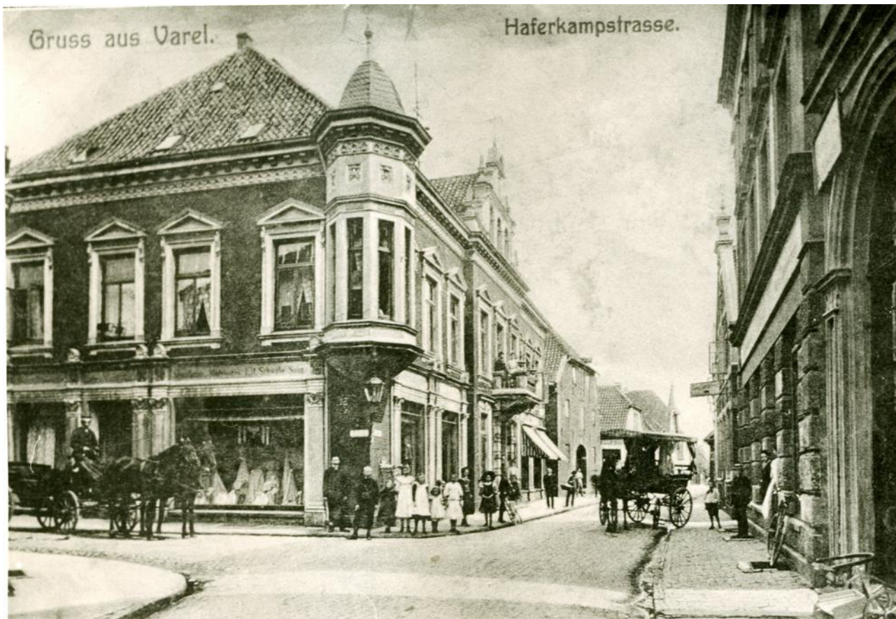
Abb.: Kaufhaus Schwabe in der Haferkampstraße in Varel. Bild um 1900. Heimatverein Varel.
