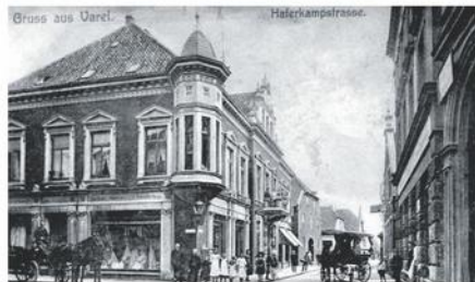
Das Geschäftshaus Schwabe in der Haferkampstraße wurde 1974 abgerissen. BILD: HEIMATVEREIN VAREL
