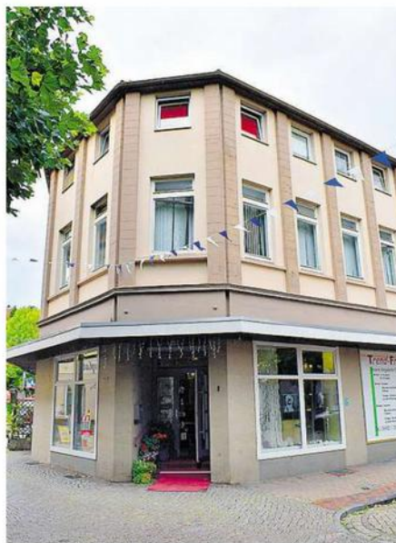
Heute ist das Gebäude in einem eher schlichten Zustand gehalten.
