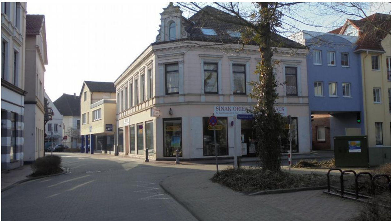
Abb.: Foto des Gebäudes Haferkampstraße 8 von 2018.
